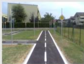
Realizzazione segnaletica stradale orizzontale in formato "miniatura" per circuiti didattici
