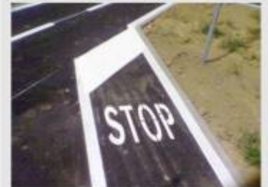
Realizzazione segnaletica stradale orizzontale in formato "miniatura" per circuiti didattici
